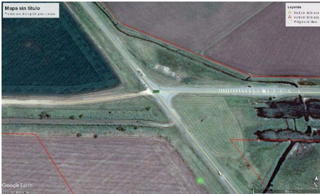
Imagen 8: Intersección existente R. P. N° 73 con R. P. N° 72
