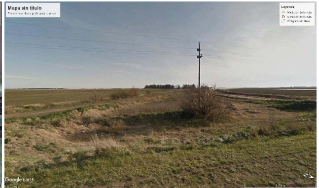
Imagen 9: Vista terraplén R. P. N° 72 y vías F. C. N. G. R.
